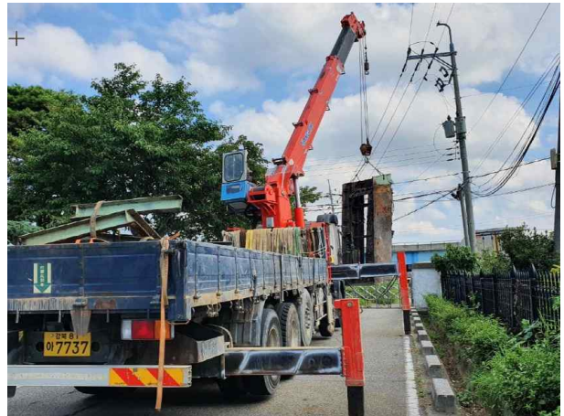
전하중계펌프장 세목스크린 4대 철거 이송 차량(7828) 계근 측정
